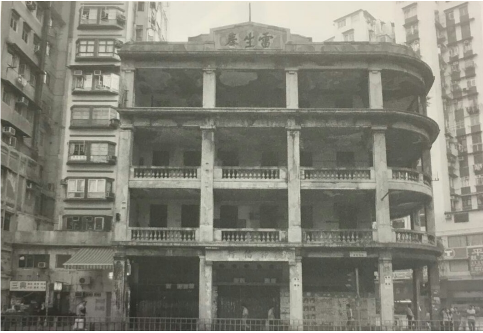
裝上圍廊玻璃組塊前的前外廊
